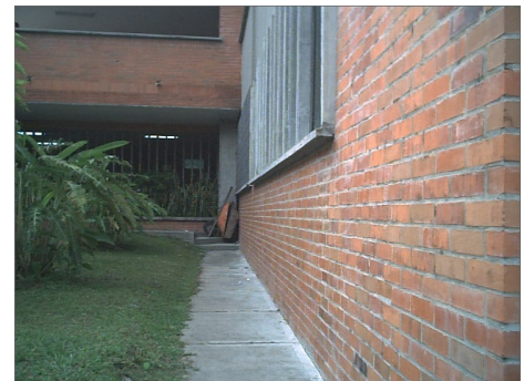
Pared exterior de la sala de sistemas
