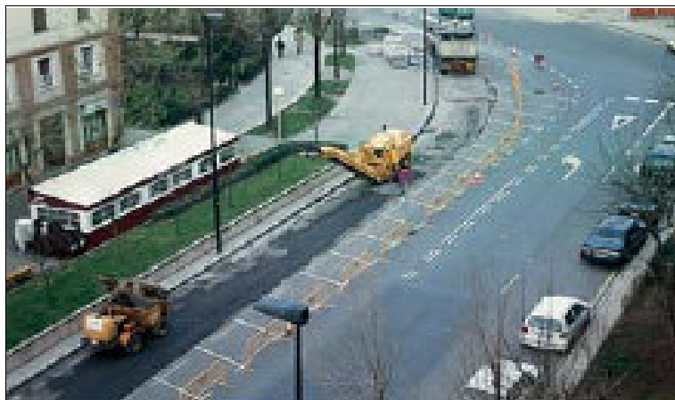
Imagen 11. Senda-bici del tipo carril-bici protegido en construcción en Elorrieta (Bilbao)
