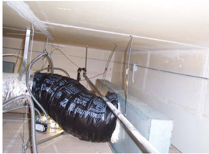
Linear Diffuser VAV Box
