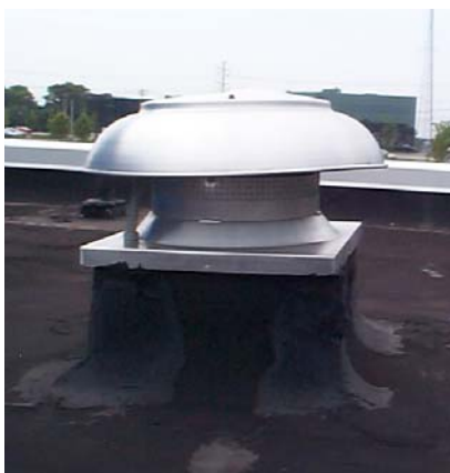
Typical Down Blast Fan
