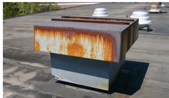
Kitchen Hood Exhaust Fan EF5 3,400 SCFM
