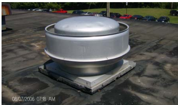
Exhaust Fan EF6 4,000 SCFM
