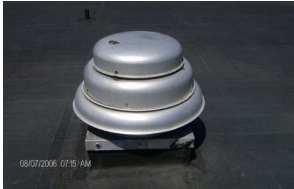
Exhaust Fan EF1 (1 of 4 typ) 1,000 – 2,600 SCFM
