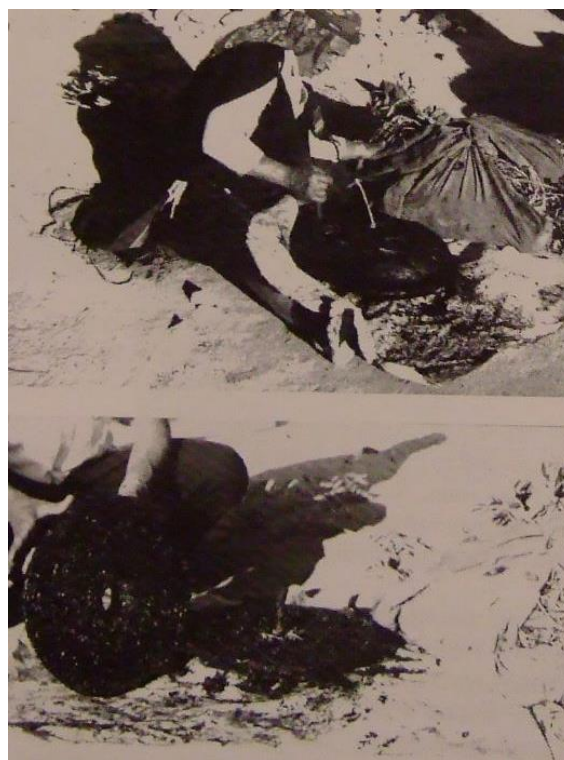
Fig. V.26: Molino rotatorio manual empleado en la molienda de olivas y apertura del molino tras la molienda. Litchfield, 1984, p. 341.
