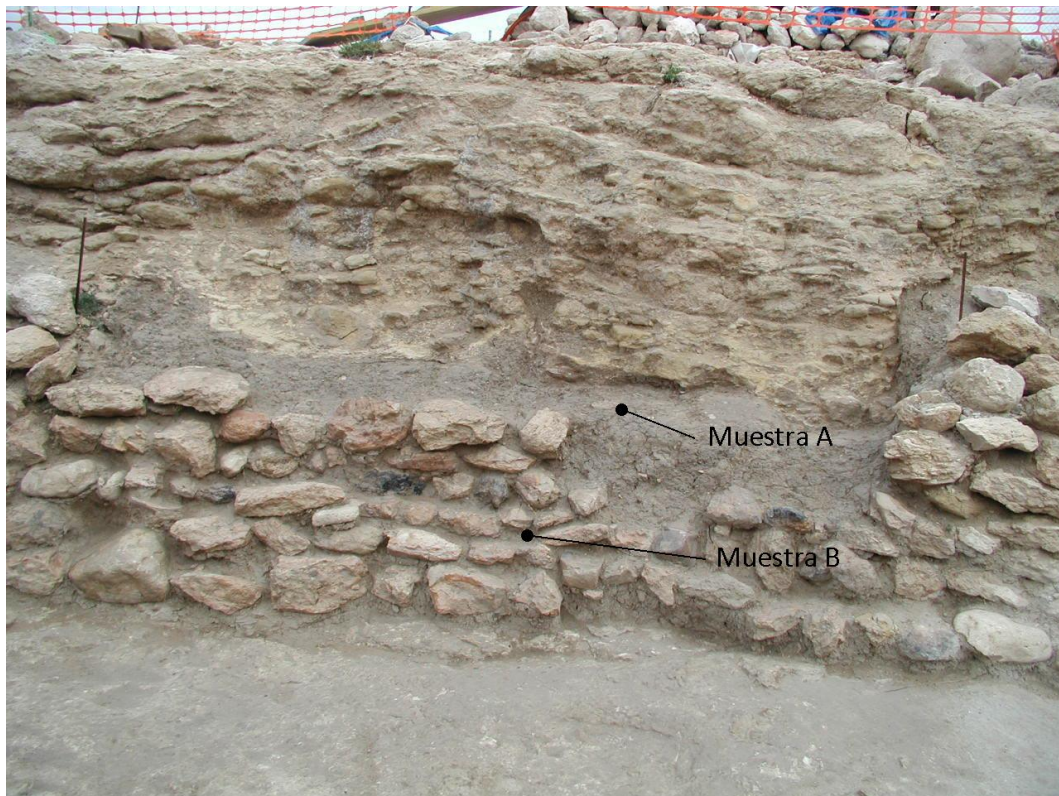
Fig. 8.22. Localización de las muestras A y B del muro / talud de Cisterna 1.
