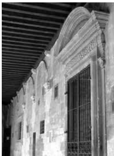
Portada de acceso a la capilla de la Cinta desde el claustro
