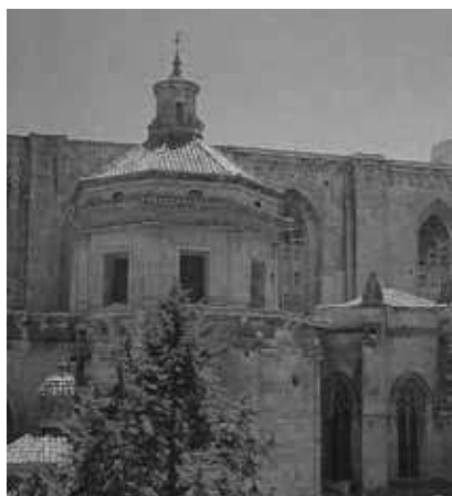
Exterior de la capilla de la Concepción de la catedral de Tarragona. Iniciada en 1673.
