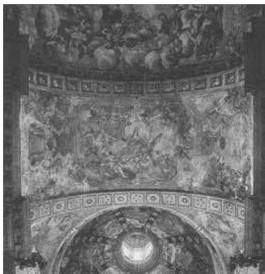
Vista de las bóvedas de la capilla de la Cinta
