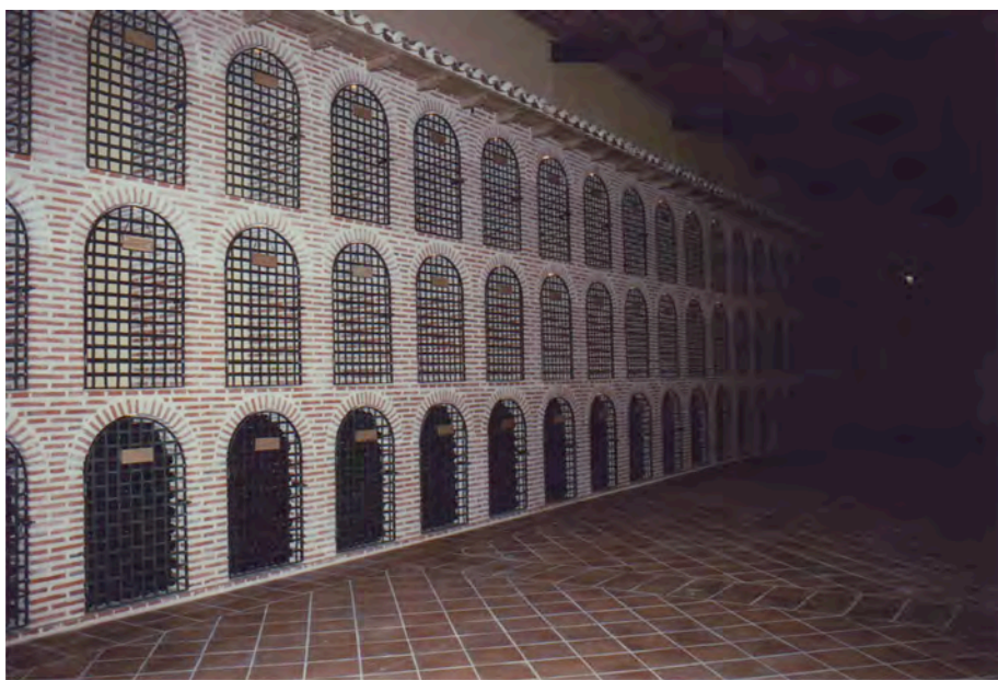
Fotografía nº 66.- Cava de botelleros en bodega.
