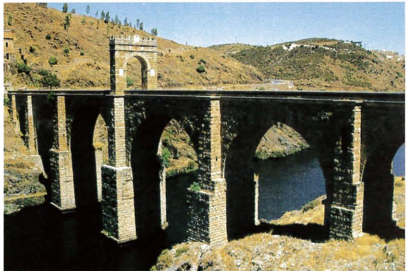
El pont d'Alcántara (Cáceres) sobre el riu Tajo, del darrer quart del segle I dC, un dels millors exemples de l'enginyeria romana a Hispania.
