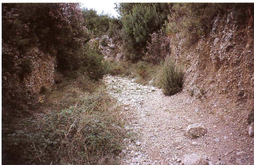
Rampa de descens de la via a la vora meridional del riu Cervol.
