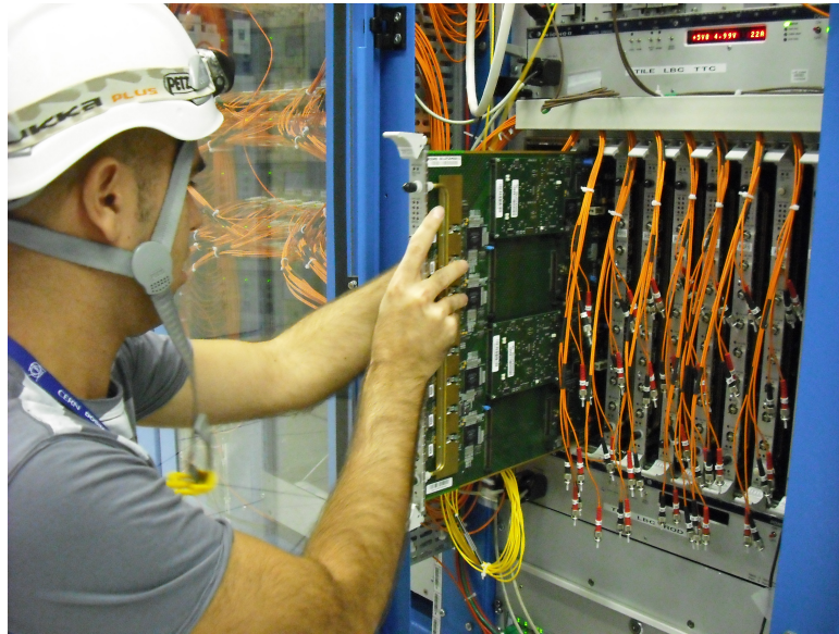
Figura 9.9: Instalación de los módulos ROD en USA15.
