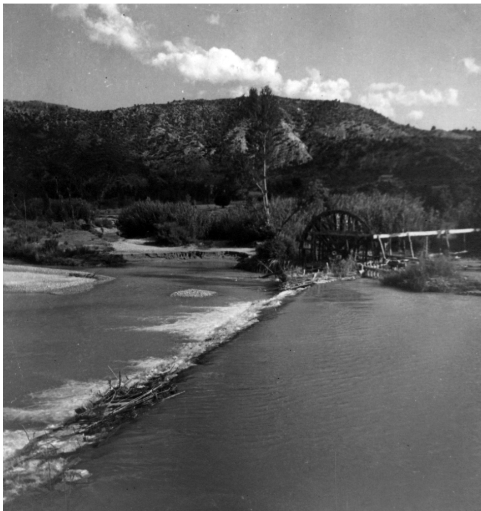
Figura 7: Presa y rueda para riego, en el kilómetro 258 del Itinerario .
