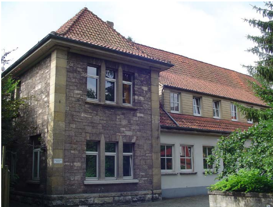
Fotografia 3 Exterior de l'edifici complementari del SEMINARI PEDAGÒGIC
