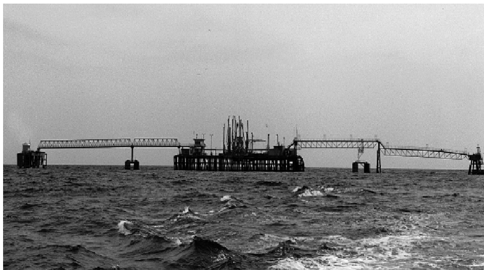
Figura 5. Observatorio universitario marino (izquierda de la foto). Este observatorio está situado sobre la plataforma petrolífera de BPOil a 3 Km de la costa y sobre isobatas de -15 a -20 metros. Las coordenadas geográficas son 39°56'42''N y 00°01'36''E.
