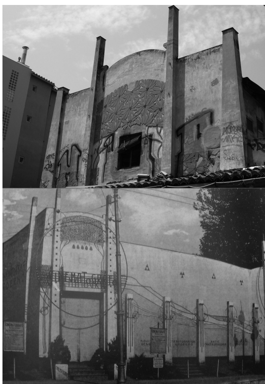
Fig. 5. Arriba: Los Cinematógrafos Caro antes de la intervención. En los pilones que flanquean la entrada aún se pueden observar las huellas de los posibles falcados de algún elemento ornamental suspendido. Abajo: Postal de los Cinematógrafos de la Exposición Internacional de Arte Decorativo de Turín (1902). El hecho de que la ventana que se encuentra en la fachada del edificio de Vicente Ferrer sea claramente un añadido posterior —compárese con los planos originales del proyecto— pone más en evidencia las semejanzas de este alzado con el del Cinematógrafo Moderno de Raimondo D'Aronco.
