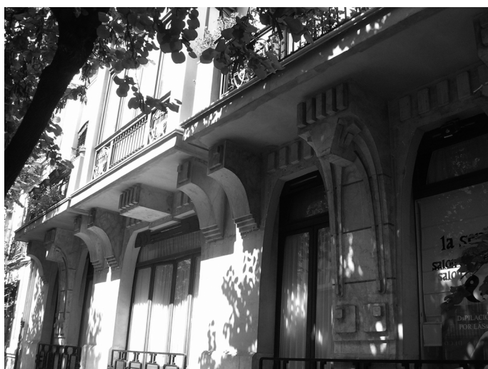
Fig. 3. Arcos y ménsulas portantes en la planta baja de la Casa Ferrer.
