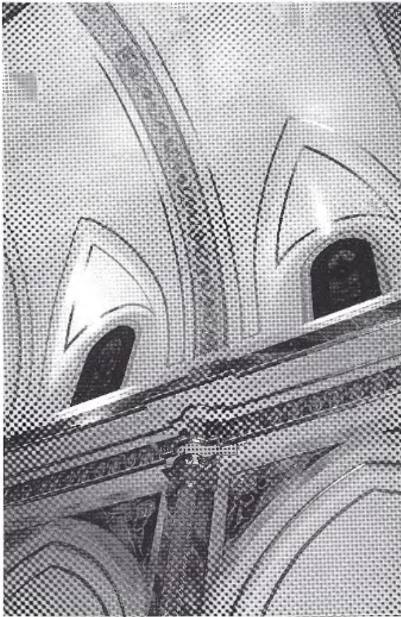
Fig. 1. Interior de la Capilla de la Comunión de la Iglesia Parroquial de Cárcer, Valencia. Detalle. Decoración de muros y ornamentos con oro falso y técnica grasa.
