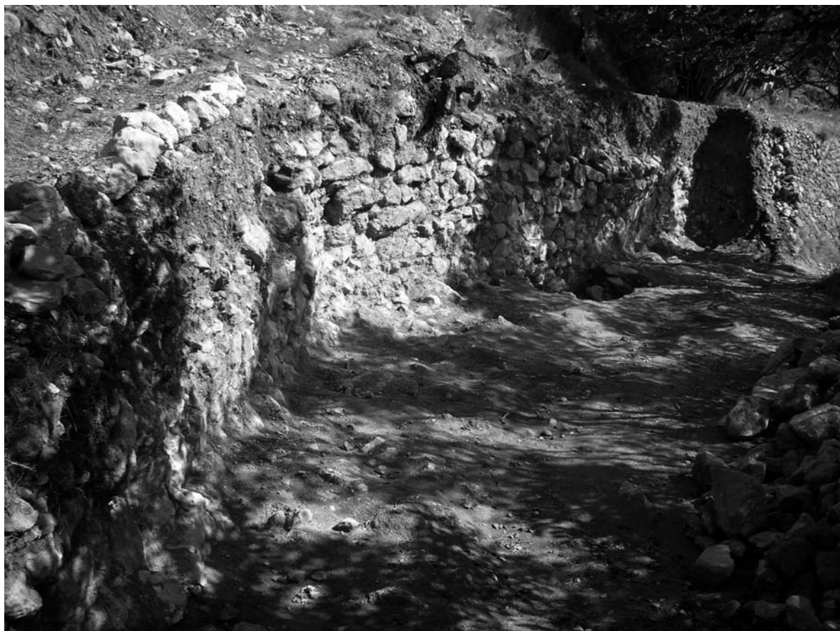
Fig. 2. Sector W3. Paramento 1304/8029.
