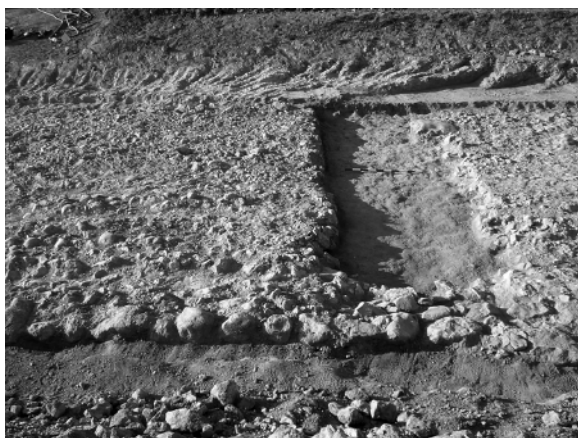
Fig. 10. Vista lateral des del est de l'excavació, amb el mur de contenció (UE 1002) en primer lloc i el sondeig 2 a la dreta.
