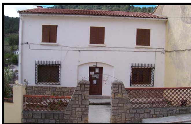
Fotografía 1.2 Consultorio Auxiliar Fotografía: Jaime Escribano. Abril de 2006, Andilla (Valencia)
