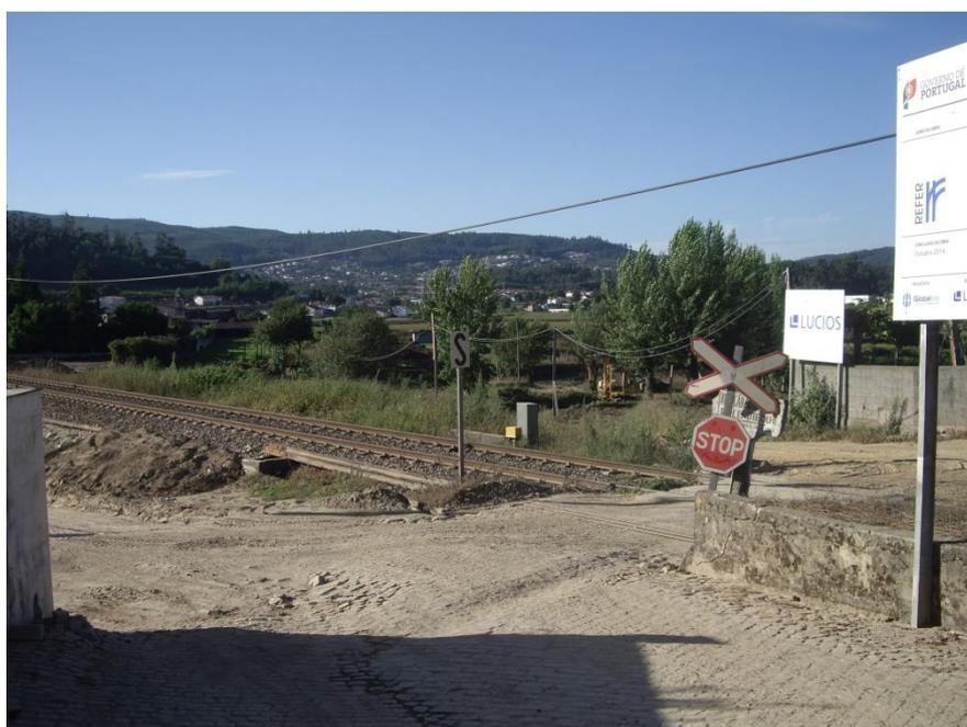
Figura 15 – Passagem de nível sem guarda
