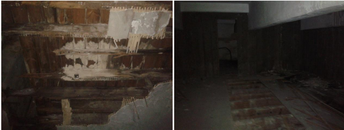
Figura 4-20 Vista inferior e superior do pavimento de madeira
