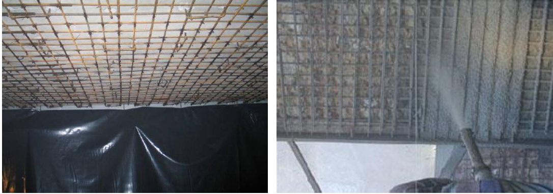
Figura 6-7 Colocação de armadura e recobrimento com betão projetado (cm-viseu.pt)
