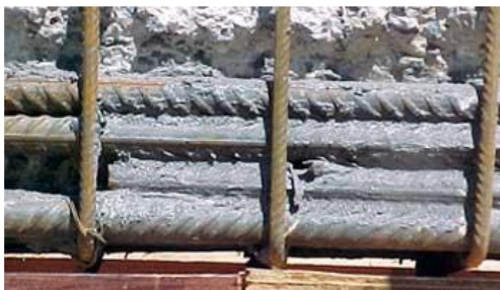
Figura 6-6 Ligação de armaduras com resinas
