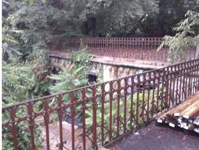
Figura 4-22 Guarda corpos do passadiço e terraço
