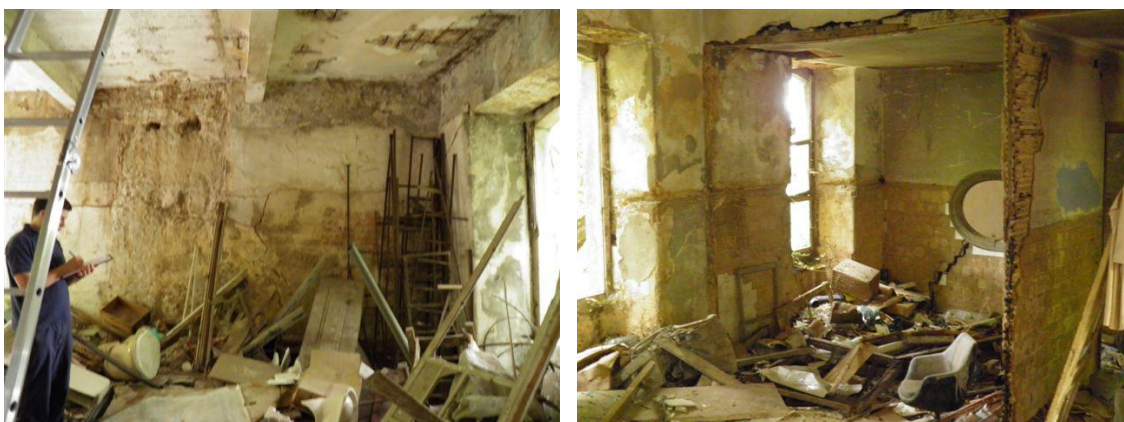
Figura 2-12 Divisão A – Parede posterior e poente, parede com óculo interior
