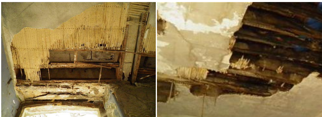
Figura 4-19 Teto falso divisão A e divisão C
