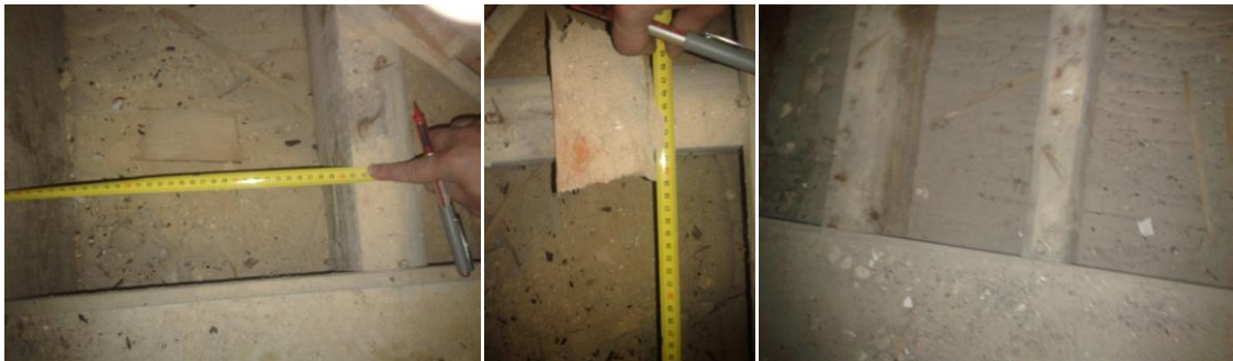
Figura 4-21 Medição da distância entre faces das travessas de madeira
