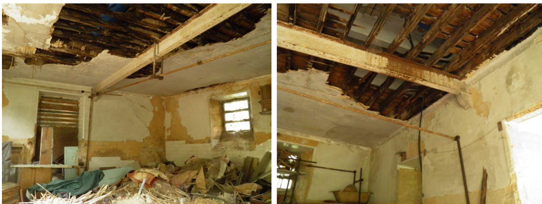
Figura 2-14 Divisão C Pavimento de madeira assente numa viga metálica.
