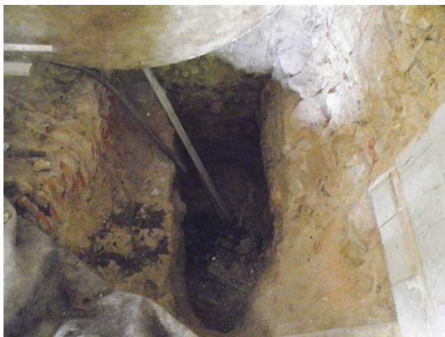
Figura 4-11 Poço no interior do edifício, divisão B
