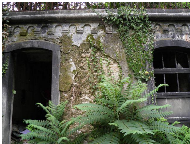
Figura 4-23 Fachada divisão B
