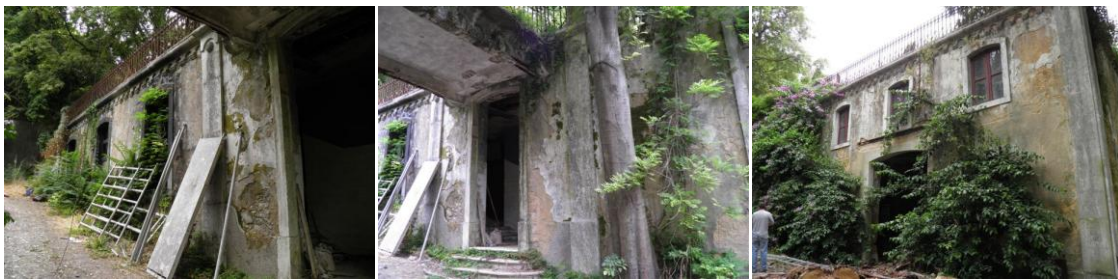
Figura 2-9 Fachada do edifício
