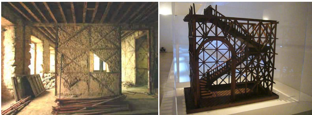
Figura 4-27 Parede na Baixa de Lisboa e modelo da gaiola pombalina (ex-LNEC)
