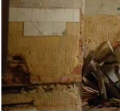
Figura 4-16 Parede de alvenaria de tijolo entre a divisória A e B
