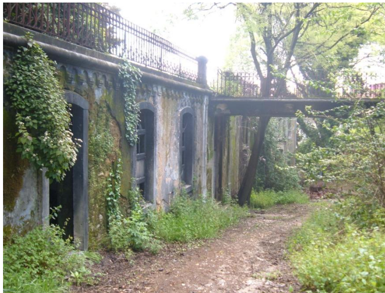
Figura 4-12 Fachada do edifício
