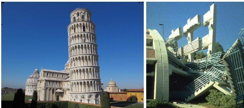
Figura 4-1 Problemas de estado limite de serviço e estado limite último (Torre de Pisa, Itália e parque de estacionamento Universidade de Nortridge, EUA)
