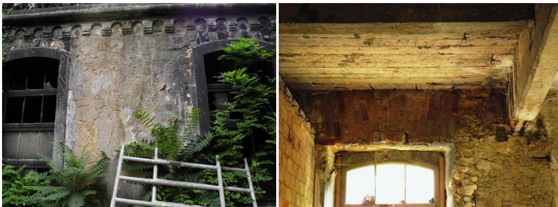
Figura 2-21 a) Fachada b) Vista interior da parede de alvenaria de pedra
