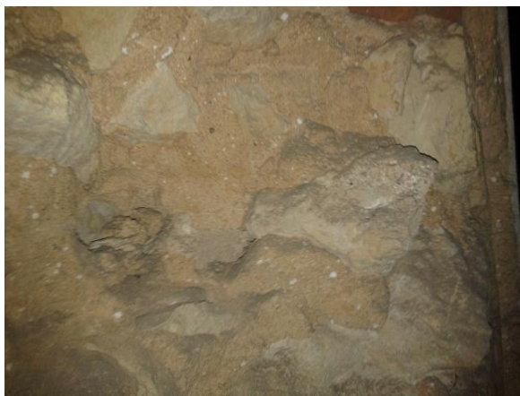
Figura 4-15 Alvenaria de pedra ordinária sem aparelhamento na parede meeira
