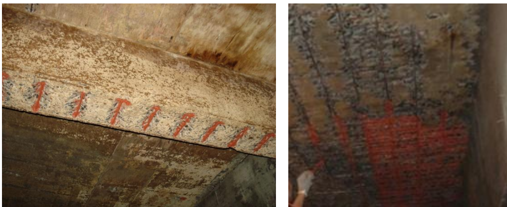
Figura 6-5 Pintura do aço exposto nas vigas e na laje
