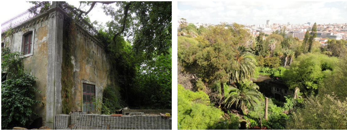
Figura 6-4 Zona poente do edifício – vista lateral e do Palácio Ribeiro da Cunha
