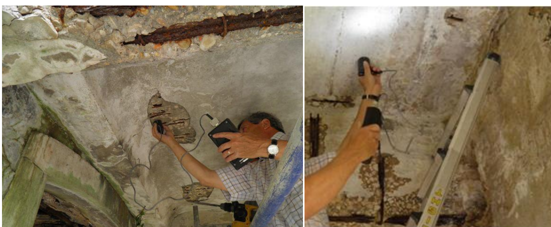
Figura 2-24 Utilização do pacómetro para aferir a espessura do recobrimento (a2p)
