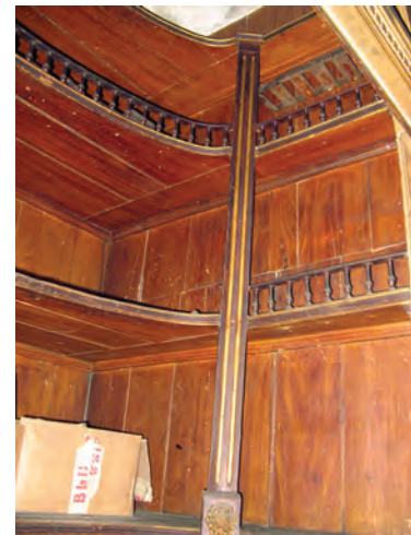
Figura 5:32 Pormenor do armário-copeiro.
