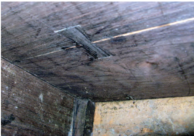
Figura 5:106A Um dos malhetes de cauda dupla na parte interior da carcaça sob o tampo.
