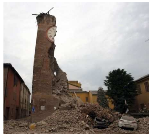
The half collapsed clock tower in Finale Emilia (La Repubblica, 2012)
