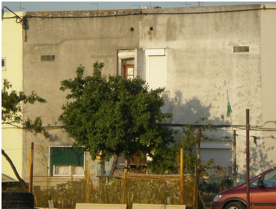
Habitações com má conservação na Rua Jaime Cortesão
