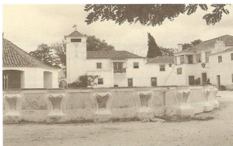
Fig. 2 - Tanque e Casas de Habitação da Quinta da Princesa, Amora (1980).
