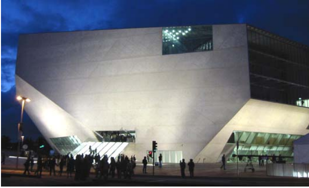
Fig.1 Casa da Musica Building 1
