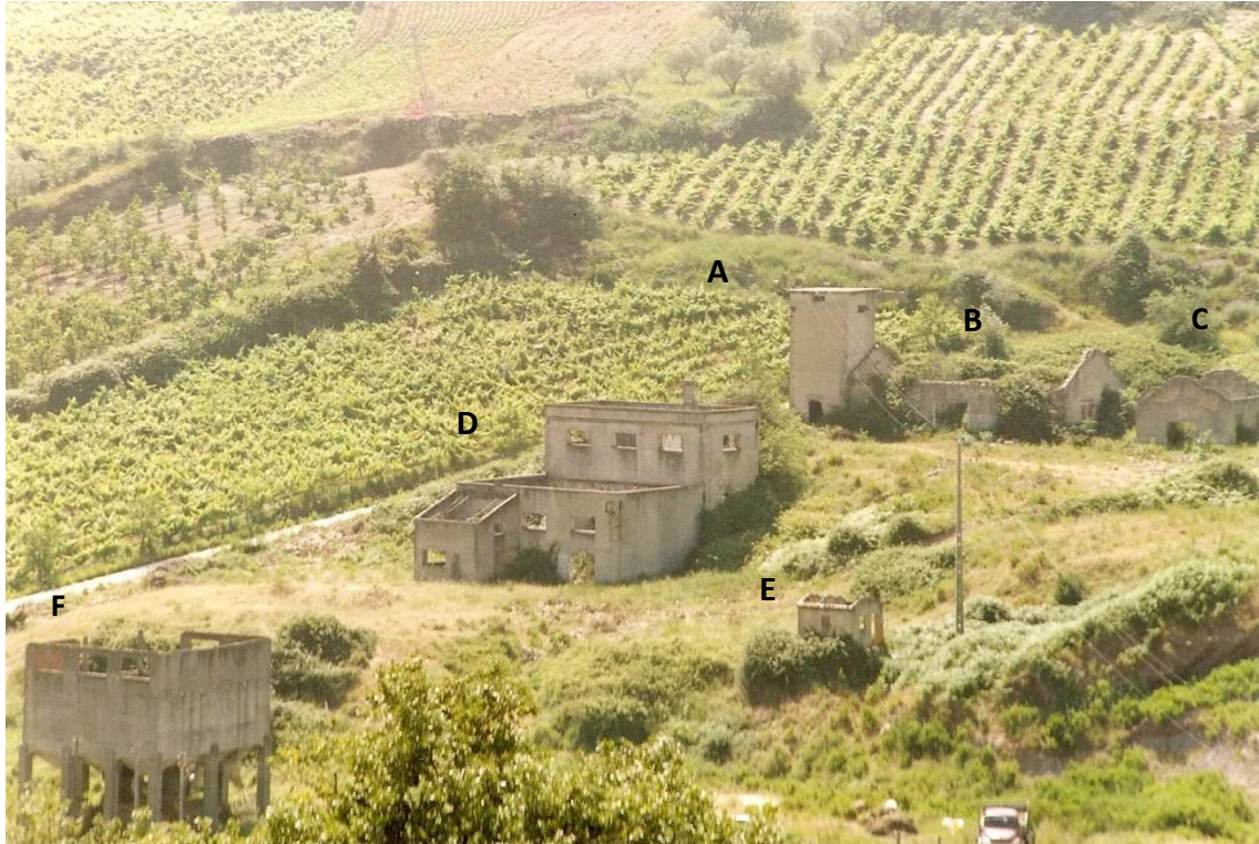
Figura 10. Ruínas dos edifícios industriais das Barrojeiras, entretanto demolidas. A – posto de alta tensão (ligado à central d Porto de Mós); B – edifício dos compressores; C – casa do guincho do poço mestre; D – oficina de preparação; E – instalações sanitárias; F Silos e tegões de carga do caminho de ferro. Foto e coleção: Batista de Matos, [198-?].
