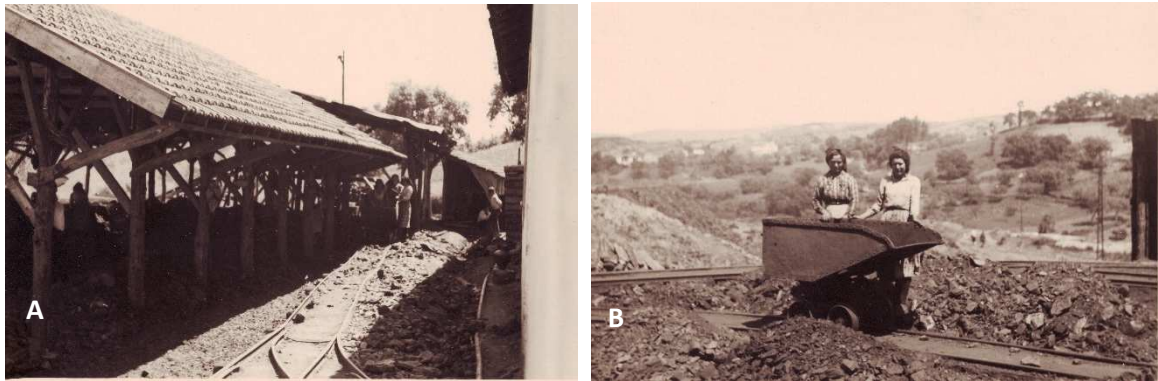
Fig 8. A – Receita exterior nas Barrojeiras e escolhedoras com um “bacalhau” (B), nome dado pelas operárias às vagonetes onde se levava o estéril à escombreira. Autor desconhecido, ca. de 1940. Cortesia AHDGEG / LNEG.
