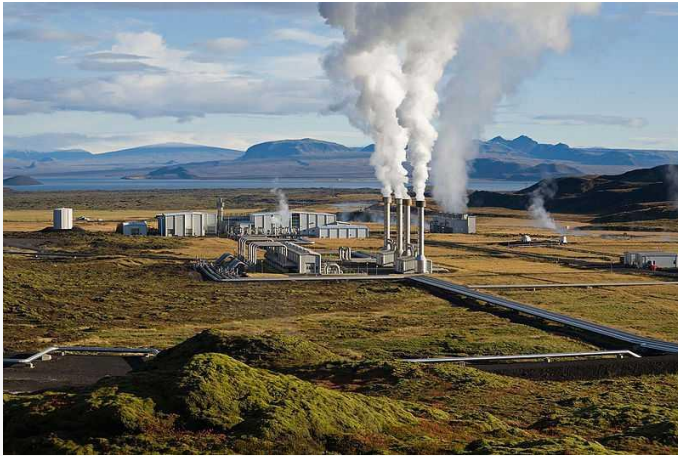
CENTRAL GEOTÉRMICA DE VAPOR SECO NESJAVELLIR (ISLANDIA)
