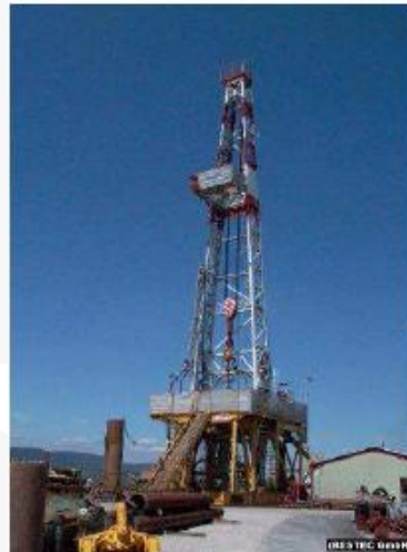
Plataforma de perforación en Soutz-Sous-Forêts, Francia.
