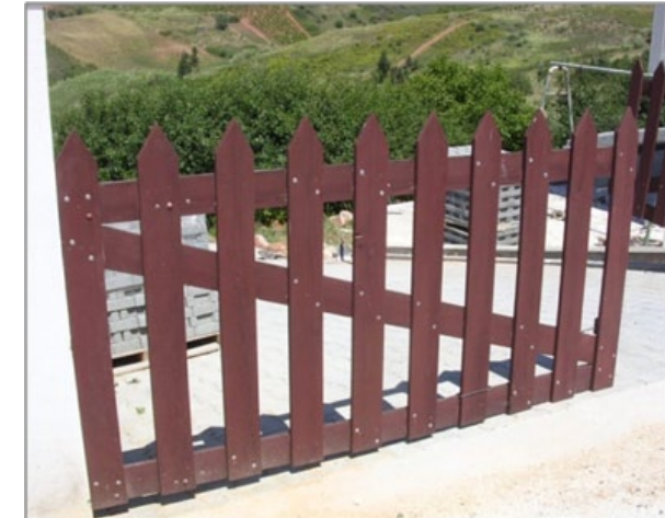
Fig. 15 - Portão de quintal em madeira de pinheiro bravo e com acabamento à base de óleo pigmentado.
