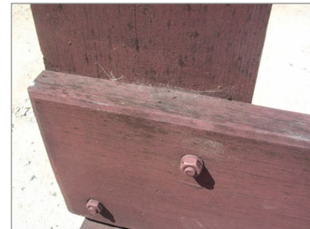
Fig. 16 - Estado do acabamento com óleo pigmentado ao fim de três anos de exposição ao sol e à chuva.
