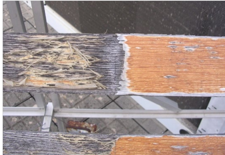
Fig. 17 - Amostra de madeira de carvalho com aplicação de verniz poliuretano em uma demão (lado esquerdo) e duas demãos (lado direito), após três anos de exposição ao exterior.
