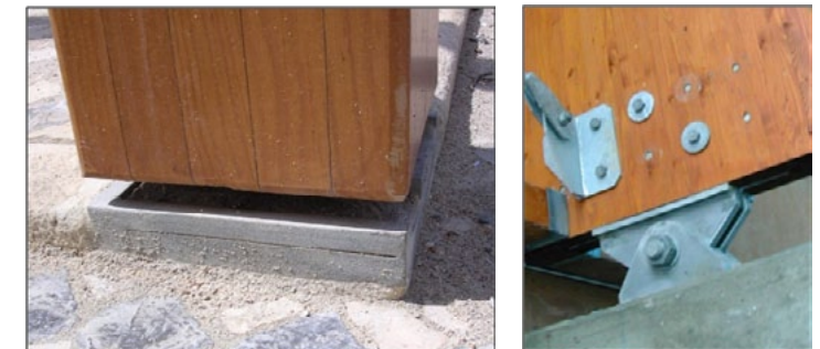
Fig. 9 - Soluções técnicas para afastar a madeira de fontes de humidade.
