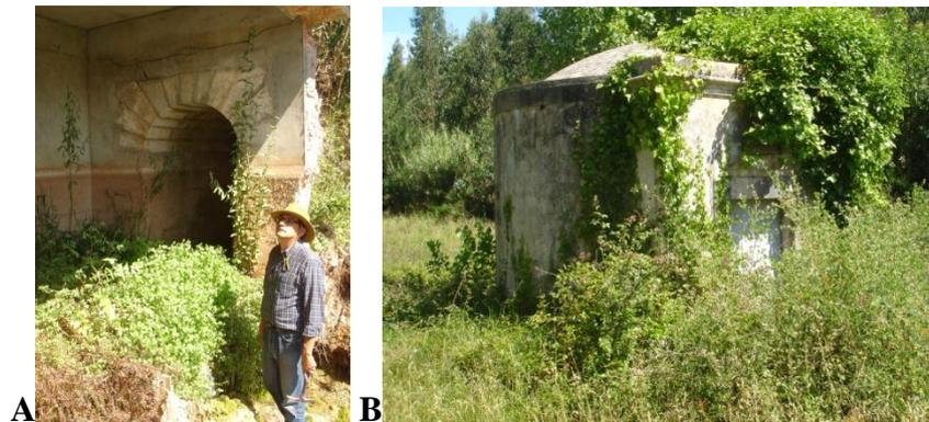
Figura 3. A - Seção final do aqueduto subterrâneo, desembocando no antigo tanque de depuração, atualmente em ruína. B - “Mãe de água” no poço nº 3, destinado a claraboia de serviço para a manutenção do aqueduto (fotos dos autores).
