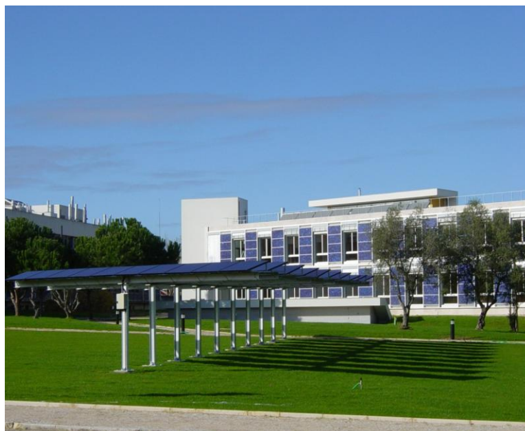
Figura 5 - Fachada Sul do Edifício Solar XXI do LNEG vista do parque de estacionamento também ele coberto com painéis PV.
