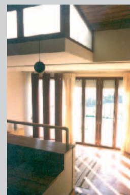
Fig. 41 – Colunas de água na Casa Solar no Porto, Arqº. Carlos Araújo e Santiago Boissel)
