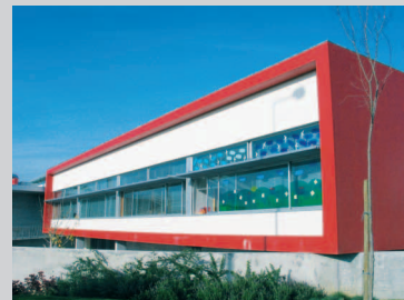
Escola do Alto da Faia Arq. Jorge Conceição e Rui Orfão
