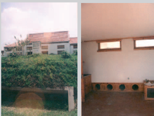
Fig. 57 – Entrada exterior e interior dos tubos enterrados
