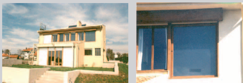
Fig. 40 Casa Termicamente Optimizada - Porto Arqº. Carlos Araújo, Arqº. Santiago Boissel
