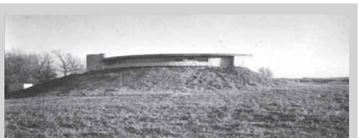
Figura 4 – Casa Jacobs II, Hemiciclo Solar; As perdas por condução são minimizadas na Fachada Norte enterrada. (www.planetclaire.org)
