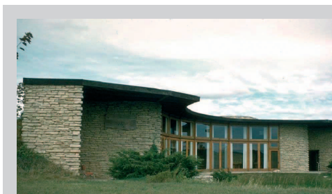
Figura 3 – Casa Jacobs II, Hemiciclo Solar; A Fachada Sul no Inverno recebe radiação desde o nascer ao pôr do sol. (www.design.ncsu.edu)
