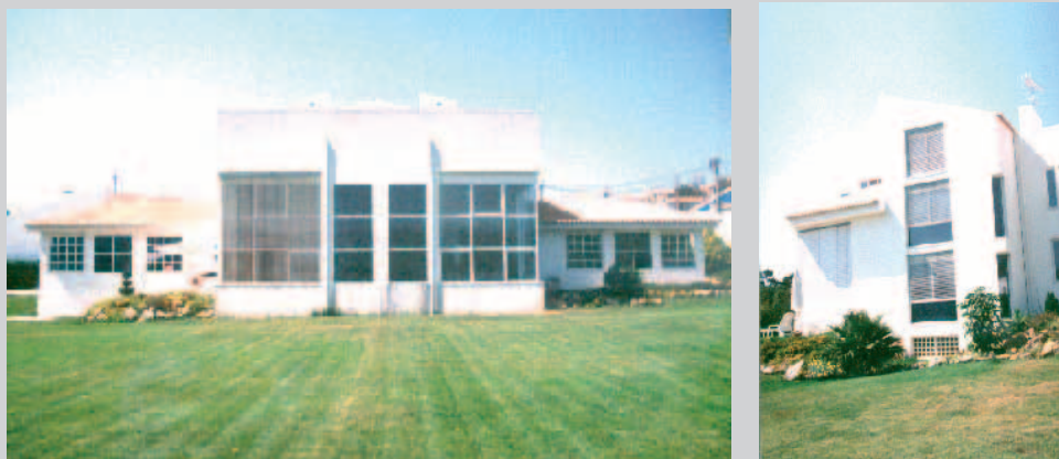
Fig. 39 Casas de Jade- Sintra (com Paredes de Armazenamento) Arq. Lúvia Tirone
