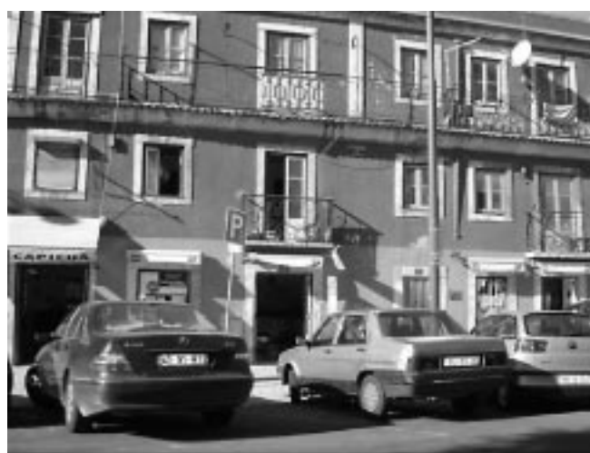
Fig. 3f - Local dos Banhos do Mosteiro de Alcobaça (parede traseira deste edifício).
