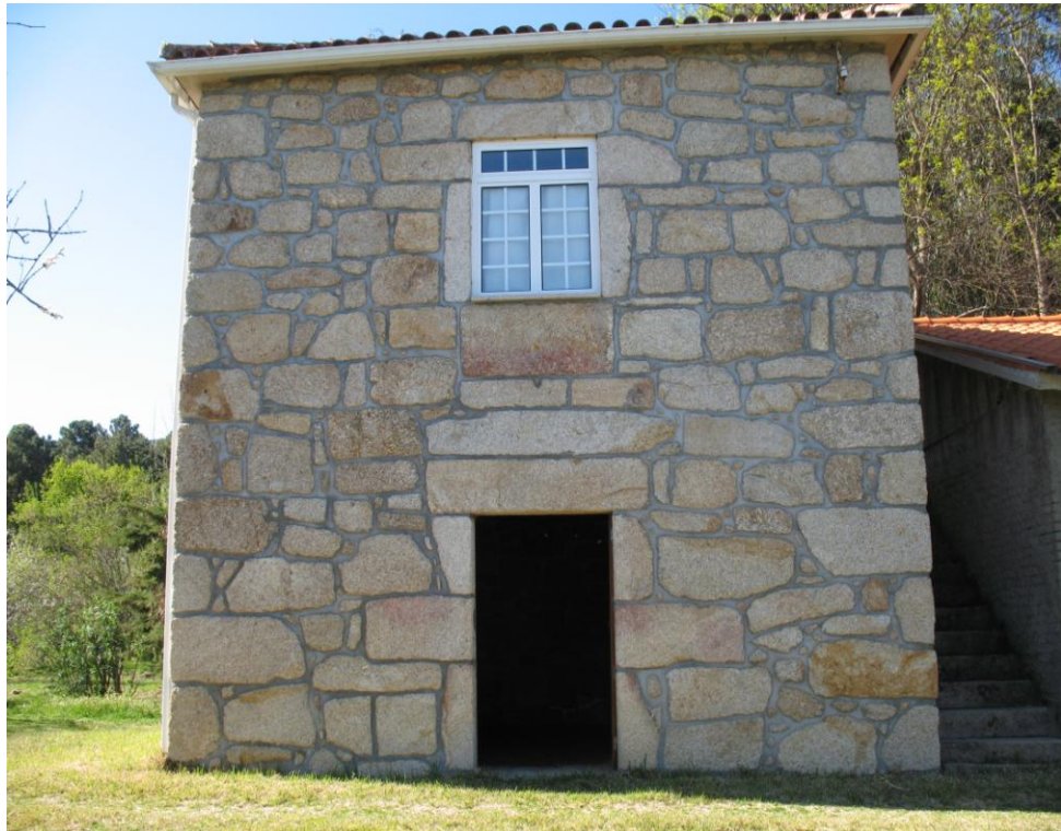
Figura IV. 3. 1. 1 - Edifício da sinagoga.
