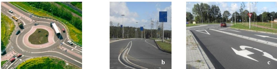
Fig.3. Turborotunda: (a) imagem de uma turborotunda; (b) e (c) pormenor da delimitação das vias na entrada e saída (Leiden, Holanda)
