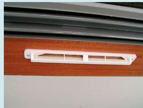
Grelha de admissão auto-regulável instalada na caixa de estore (vista de tardo)
