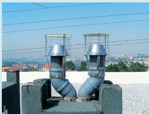
Ventiladores estáticos instalados nas condutas das instalações sanitárias
