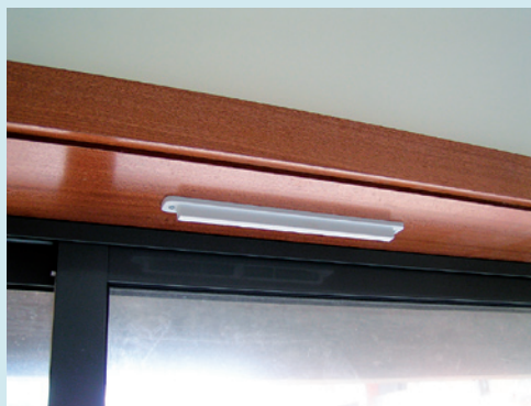
Grelha de admissão auto-regulável instalada na caixa de estore (vista de frente)
