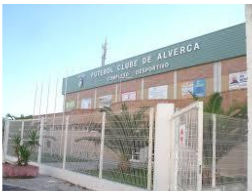
Figura 3 - Pavilhão Desportivo FCA
