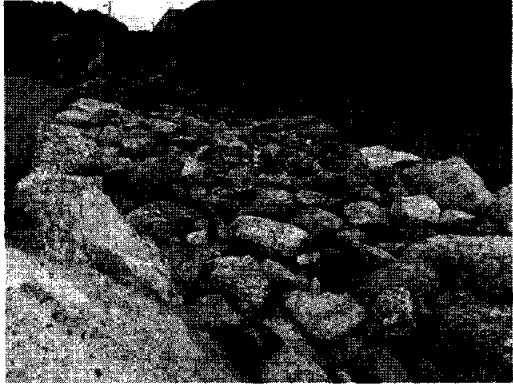
写真3 石積みの工夫
