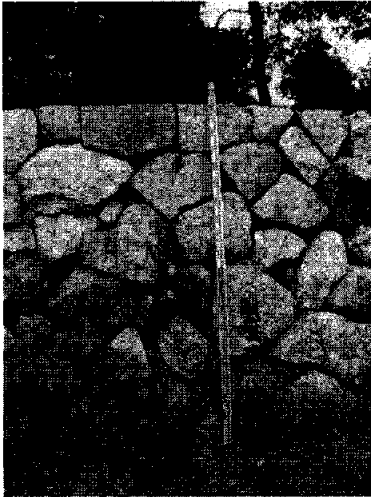
写真2 修復・増強されたシシ垣
