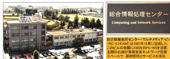
図 25 総合情報処理センター建物と CNS の銘板
