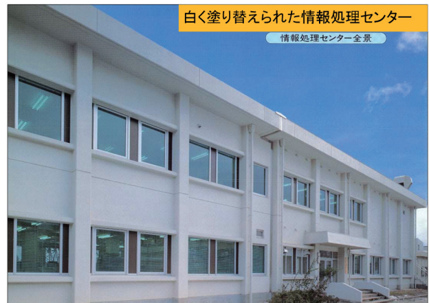
写真8 左側を増設した白くなった情報処理センター建物 旧計算機室は日本語グラフィック端末室となり、TSS 端末51台が設置され、これを使用した各学部 のプログラミング教育にも活用された(写真9)。
