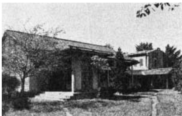
附属図書館薬学部分館(右端書庫)
