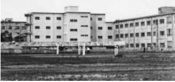
理学科の五福移転時（昭和36年）の校舎（一期工事完成時）
