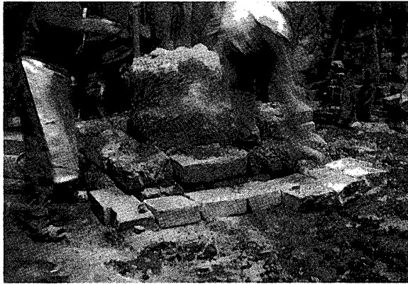
①—特に薪に近い下方の部分のキレツが激しく、湯の漏れを防ぐためレンガで囲い土をつき固める。
