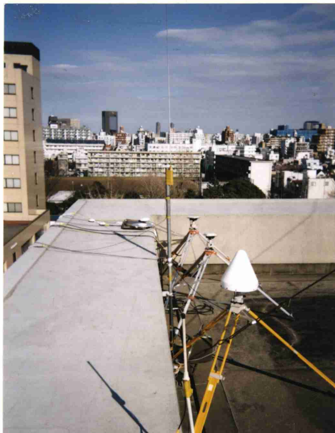
写真 3: GPS アンテナの設置状況
