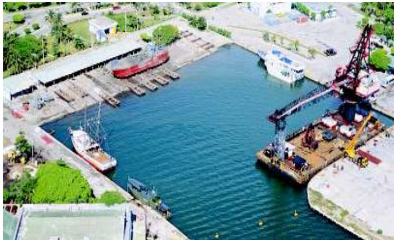
La Planta Bocagrande, es un astillero ubicado en la Bahía interna de Cartagena de Indias, en el Sector Turístico de Bocagrande. Este astillero cuenta con una capacidad máxima de levante de 1200 toneladas a través de un sistema tipo SLIP que utiliza una rampa independiente de 8 carros para levante transversal, 66.5
