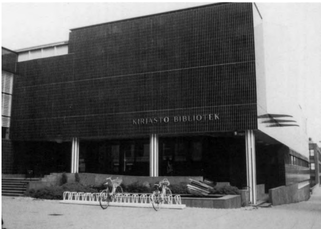
FINLANDIA. Biblioteca Pública de Helsinki (exterior).
