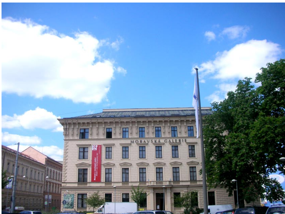
Edificio donde se encuentra la biblioteca de la Galería Morava en Brno.
