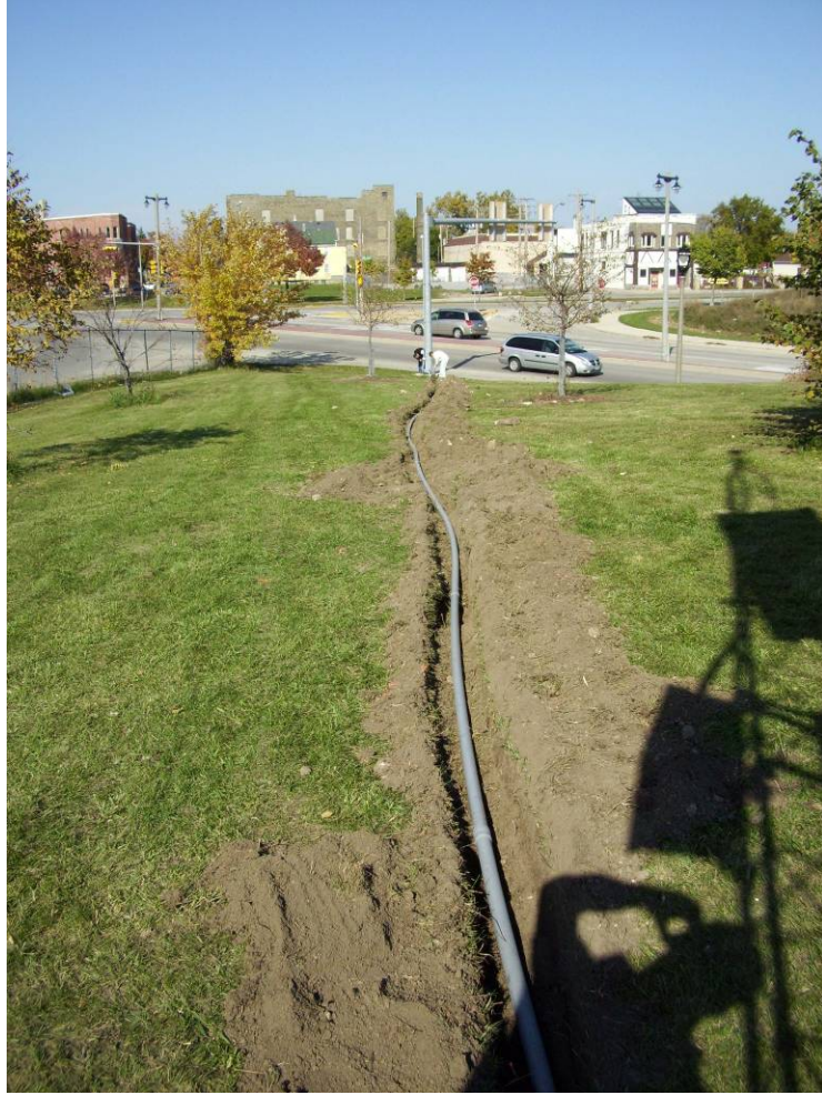
Figure 3.28 Conduit Run
