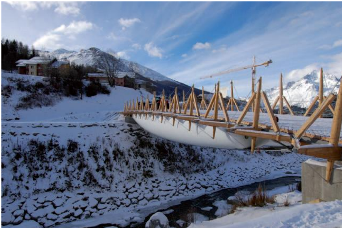
Slika 2.15: Smučarski most po tensarity principu z razponom 52 m, Francoske alpe 2005 (Pohl & Nachtigal, 2015).
