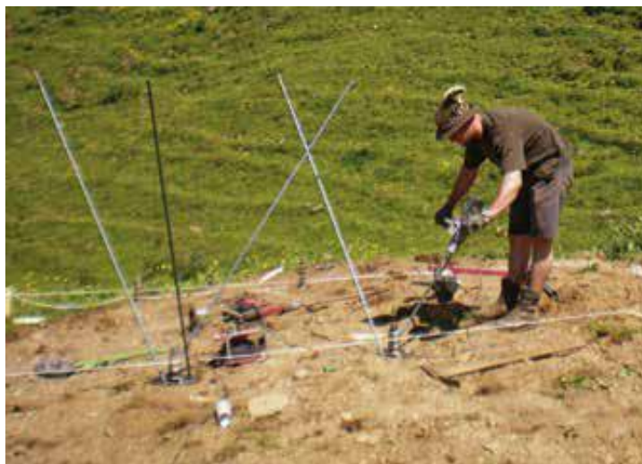
Slika 4.4: Montaža temeljnih sider (Okonek, 2016).
