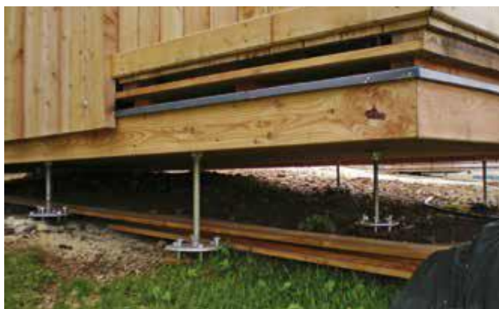
Slika 4.6: Detalj stika objekta in sider (Okonek, 2016).
