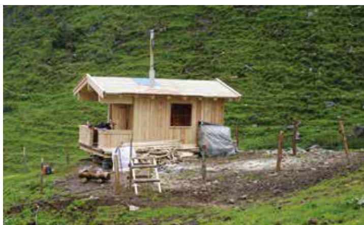
Slika 4.5: Izgrajen objekt na sidrih (Okonek, 2016).
