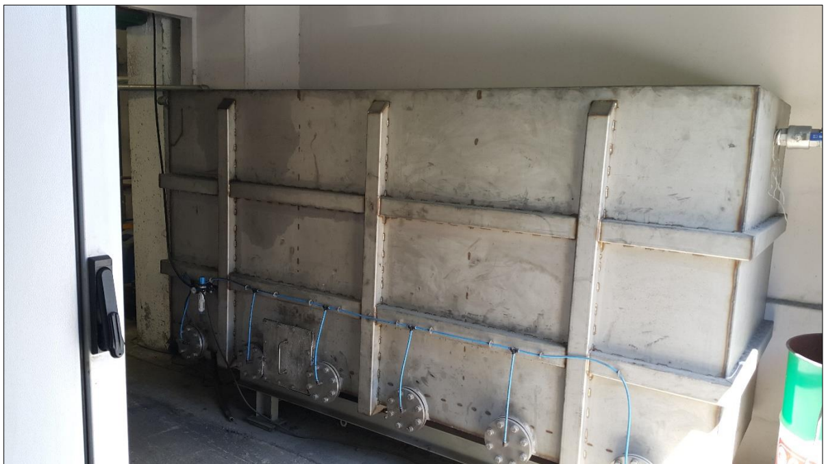
Slika 4-11. Kolona z aktivnim ogljem
