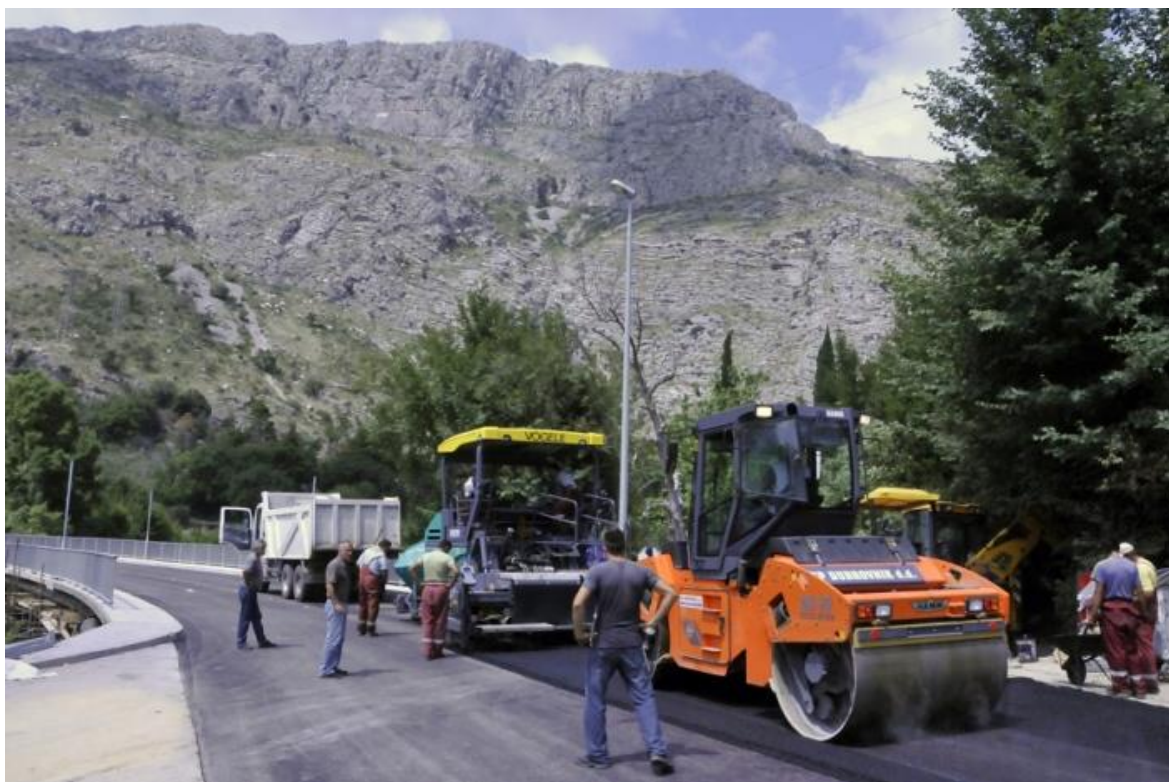
Slika 27: Primer polaganja asfalta 89
