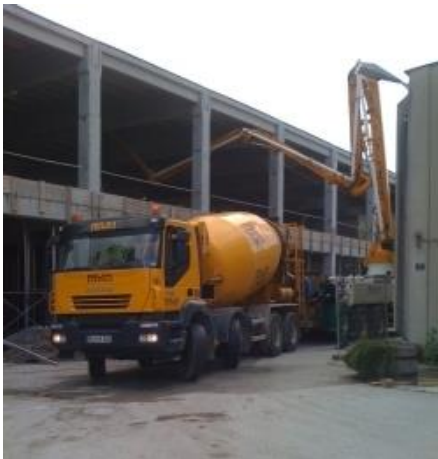
Slika 26: Primer betoniranja z betonsko črpalko 86
