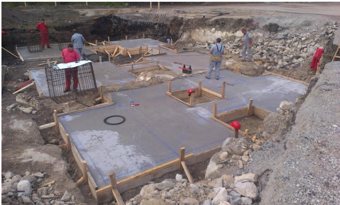
Slika 29: Podložni beton pasovnih temeljev
