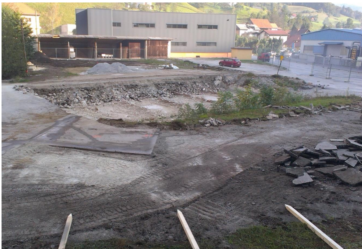
Slika 28: Prikaz izkopa gradbene jame
