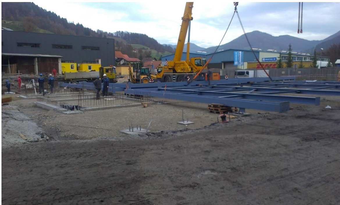
Slika 30: Postavitev jeklene konstrukcije
