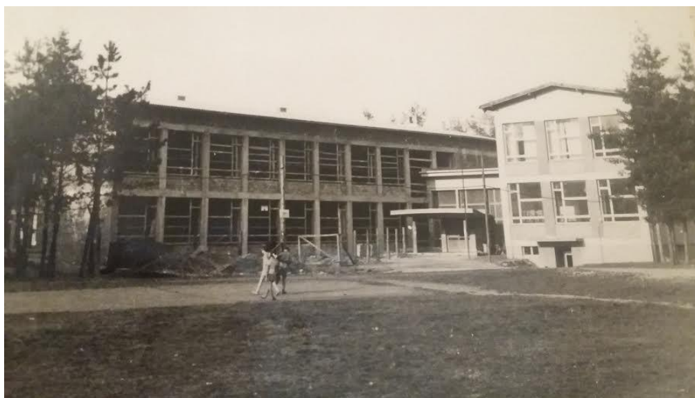
Slika 7: Gradnja nove šolske zgradbe
