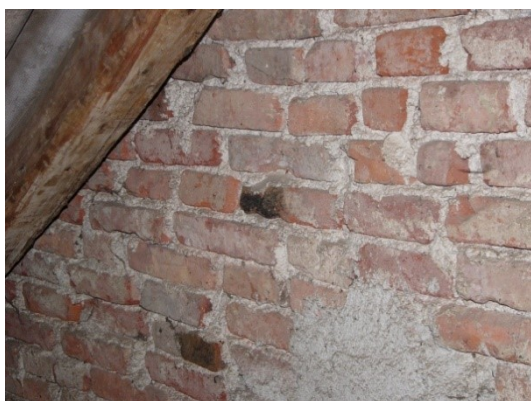
Slika 6.3-9: Zatrejni zid objekt 4
