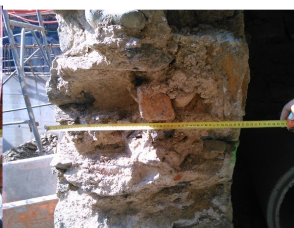
Slika 7.1-5: Meritev debeline vmesnega nosilnega zidu v kleti
