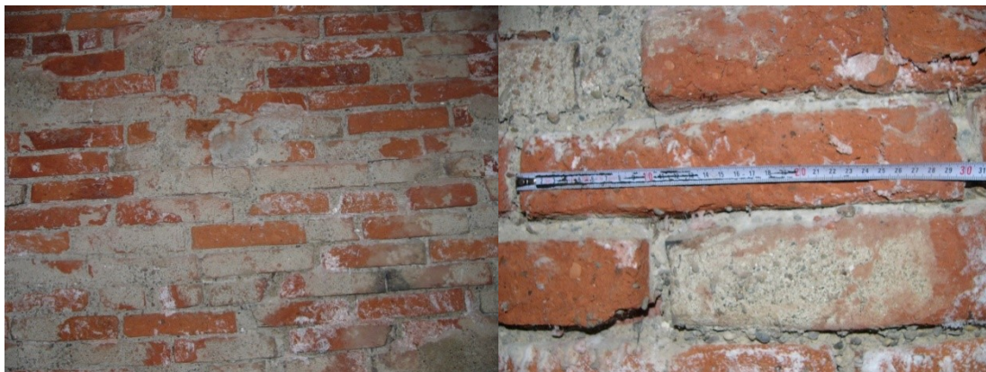
Slika 6.3-1: Zid iz zidakov dolžine 29 cm v objektu 1
