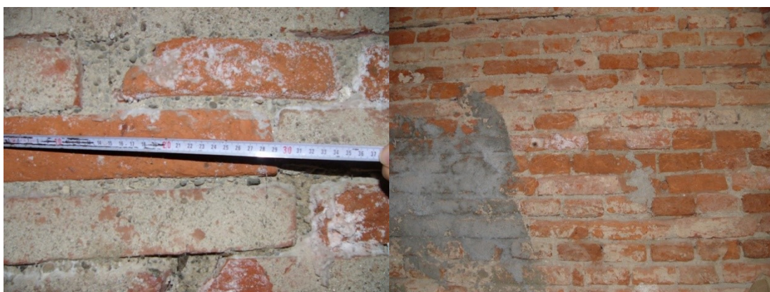
Slika 6.3-3: Zidak dolžine 29 cm v objektu 2
