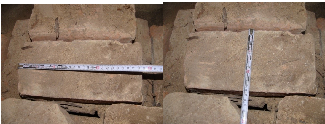
Slika 6.3-5: Zidaki dolžine 29 cm iz objekta 1
