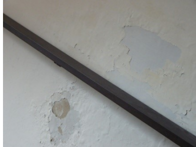
Slika 3.7-3: Odpadanje ometa
