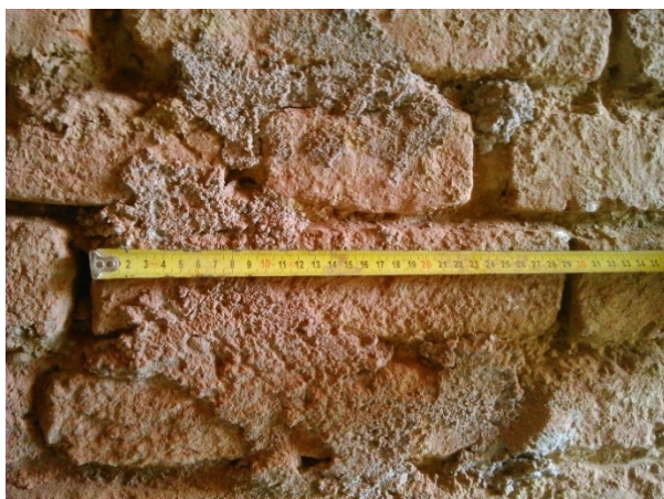
Slika 7.1-2: Meritev dolžine opečnega zidaka
