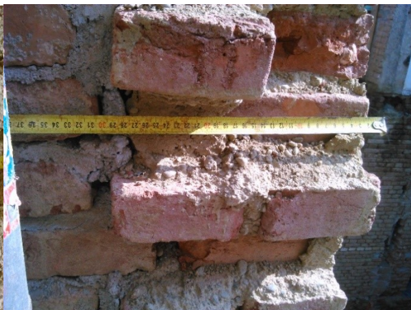
Slika 7.1-3: Meritev dolžine in širine opečnega zidaka
