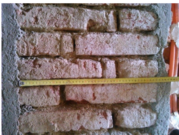
Slika 7.1-4: Meritev debeline nosilnega zidu v prvem nadstropju
