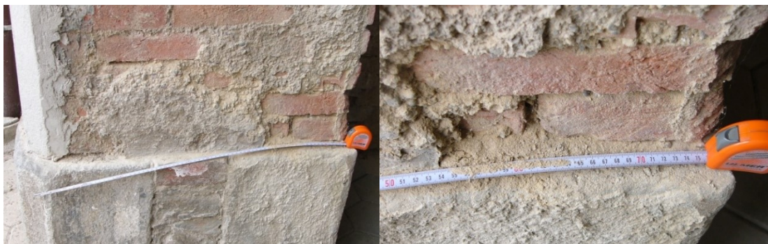
Slika 6.3-7: Debelina pritličnih zidov objekt 1
