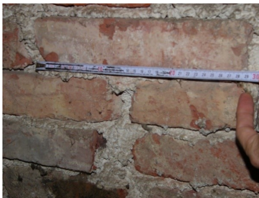
Slika 6.3-10: Zidak dolžine 29 cm v objektu 4
