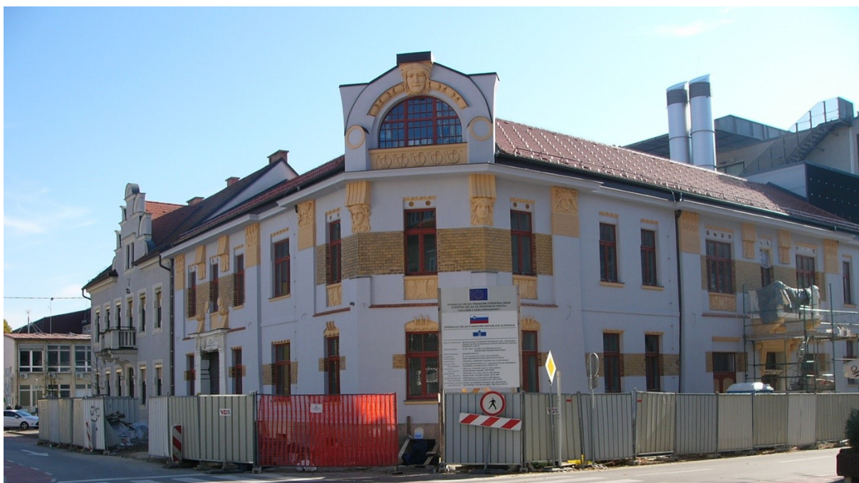
Slika 7.1-1: Baroničina hiša med obnovo
