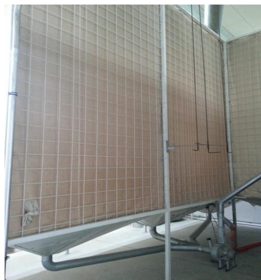
Slika 2.4 Silosi za stabilizacijo materiala
