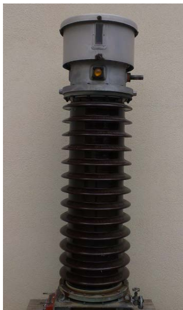
Slika 13: Visokonapetostni merilni transformator VPU - 123
