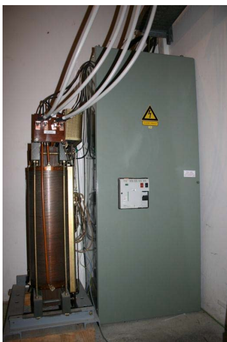
Slika 2: Niskonapetostna stikalna celica
