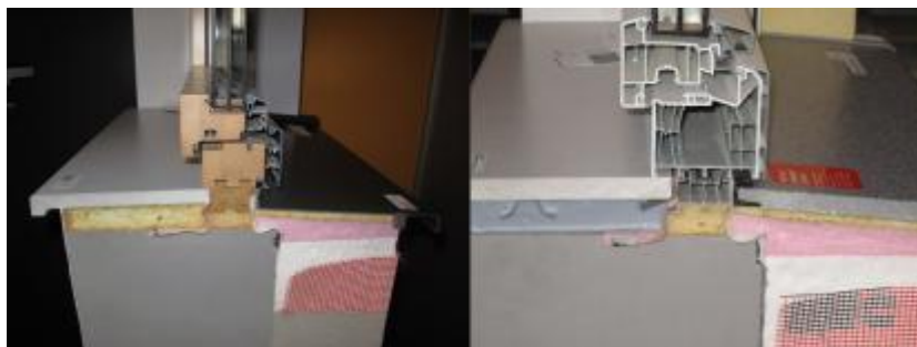
Slika 3-2: Vgradnja oken po RAL standardu ( http://www.mojmojster.net/ )
